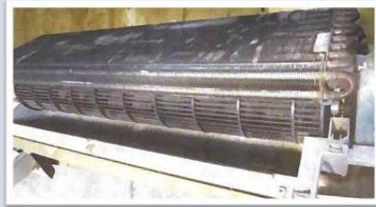
แบบพัดลมดูดอากาศผ่านชุดคอยล์เย็น
