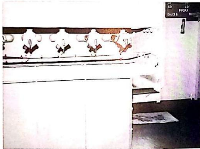
Fig. 851 Conexiones de aire comprimido para limpieza de los filtros
