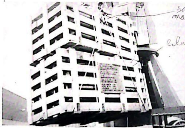
Fig. 393 Lingada empleando el morrongo. La eslinga se engancha al gancho del morrongo cómodamente desde el suelo.
