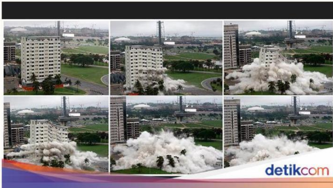
Gambar 1. Perobohan Gedung Dengan Peledakan Sumber : detiknews.com
