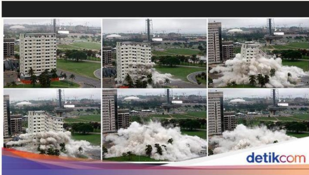
Gambar 1. Perobohan Gedung Dengan Peledakan Sumber : detiknews.com
