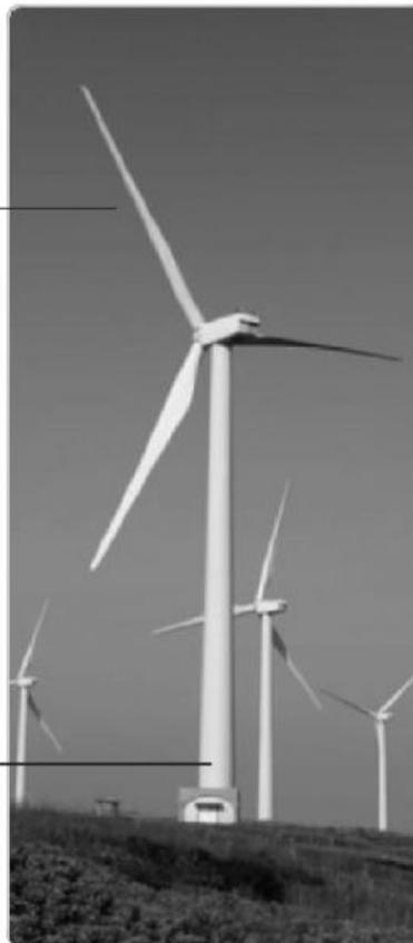
La góndola es la carcasa que protege el multiplicador y el generador. El multiplicador aumenta la velocidad de giro y el generador convierte la energía en electricidad.
