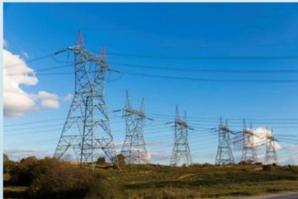
Menara Saluran Udara Tegangan Ekstra Tinggi (SUTET) menyalurkan listrik dari pusat pembangkit listrik menuju lokasi yang jaraknya sangat jauh.
