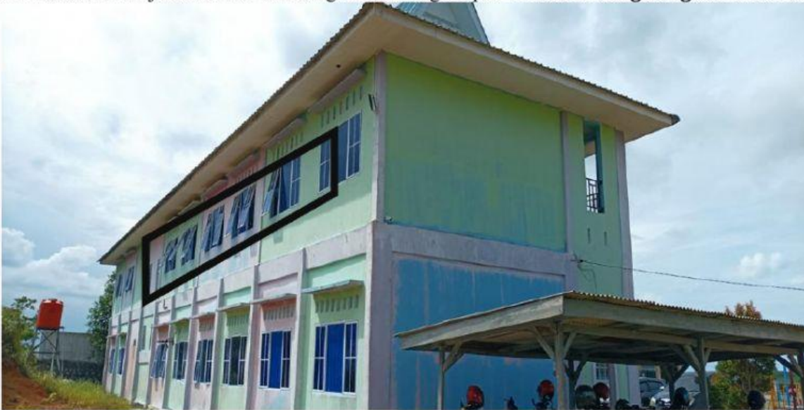
Gambar Bangunan SLB Tampak Belakang
