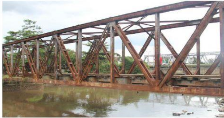
Gambar 4. Peristiwa korosi pada jembatan
