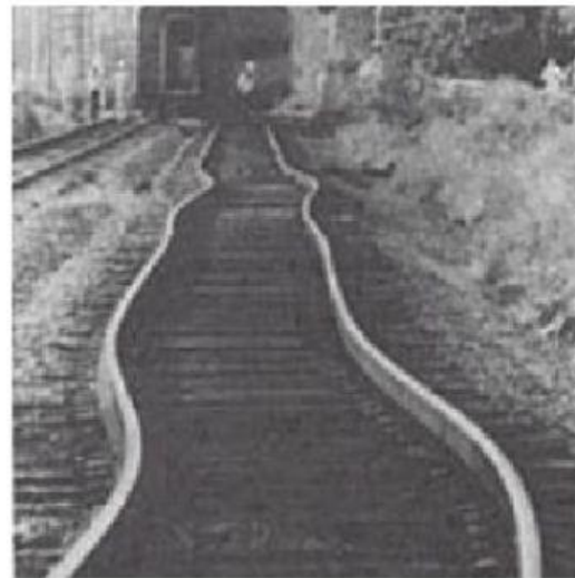
Gambar 4.15 Rel kereta api dapat melengkung akibat pemuaian Sumber : Dok. Kemendikbud
