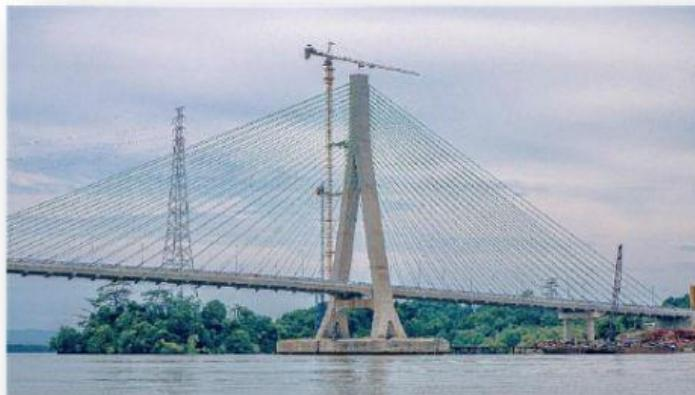
Jembatan Pulau Baling yang terletak di Balikpapan, untuk membangun struktur jembatan diperlukan perhitungan yang teliti, masing-masing tali terhubung dengan puncak jembatan sehingga berbentuk segitiga. Misalkan diambil salah satu bagian dari jembatan tersebut, akan tergambar struktur seperti berikut :
