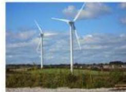
La energía eólica utiliza la fuerza del viento para transformarla en energía mecánica gracias al movimiento que provoca en las palas del molino. Después, esta energía mecánica se **convierte en energía eléctrica** gracias a un generador que funciona con una turbina de imanes para crear el voltaje eléctrico.
