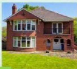
Casa de ladrillo
