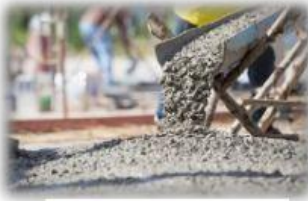
A. คอนกรีต
