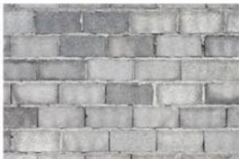
คอนกรีต
