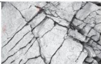
น้ำที่ซึมเข้าไปในหินทำให้เกิดรอยแตกของหิน
