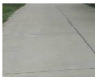
ถนนคอนกรีต
