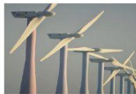
Pembangkit Listrik Tenaga Bayu (PLTB)
