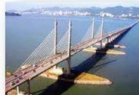
Jambatan Pulau Pinang
