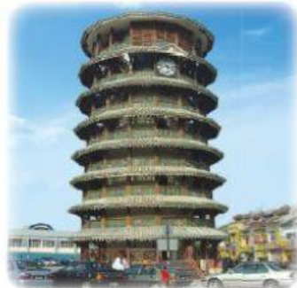
Menara Condong Teluk Intan
