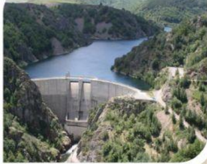
Construcción de represa
