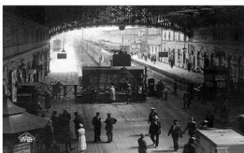
1934 год. Рига. Железнодорожный вокзал (станция Rīga Pasažieru) (photo by V. Uplītis)
