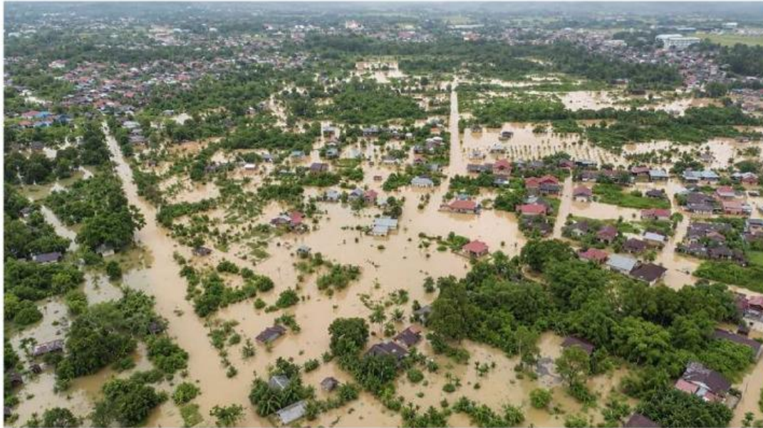
Gambar 6. Kondisi banjir di Kota Padang (Rachmawati, 2025).
