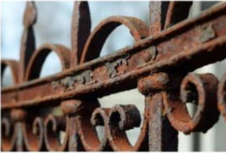
Gambar perkaratan besi Sumber: https://G8XrFtTPDEA2XGoFv
