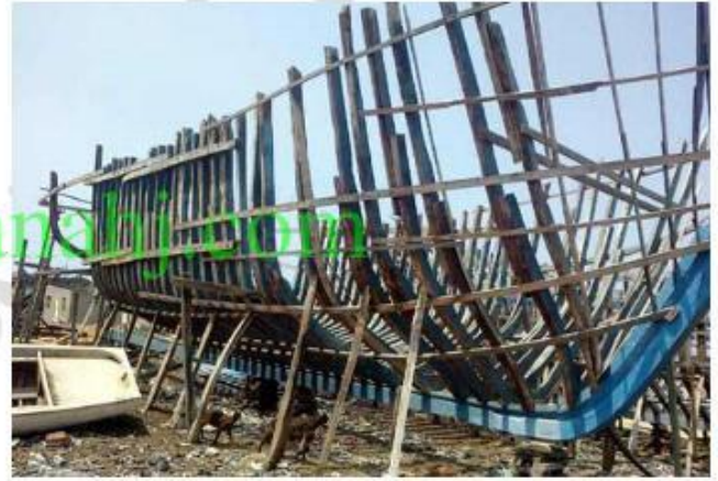
1- إنشاء الهيكل الخارجي للسفينة
