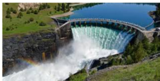
Gambar 3. PLTA mengubah energi air menjadi listrik
