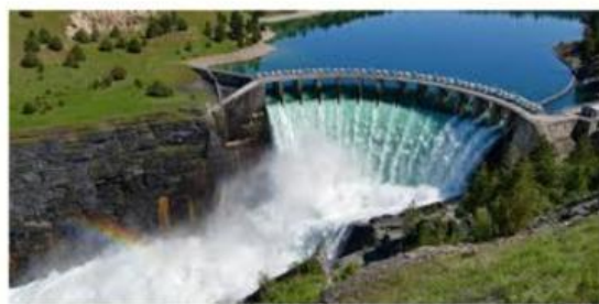
Gambar 3. PLTA mengubah energi air menjadi listrik
