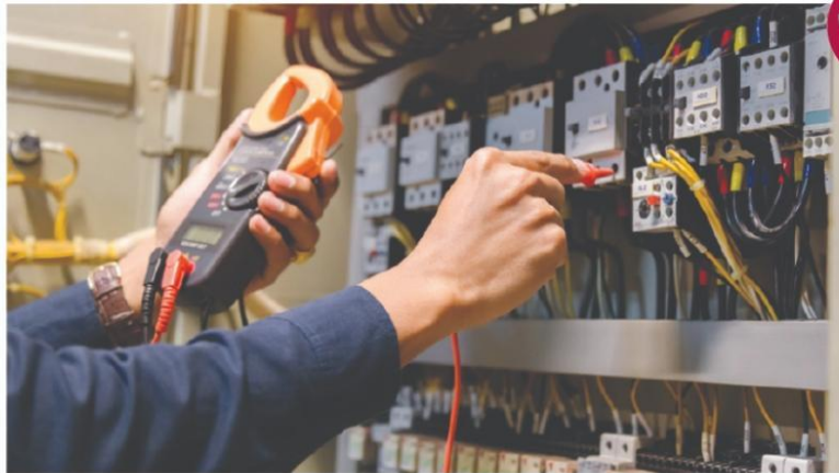
Fig. 29. Instalator echipamente electrice
