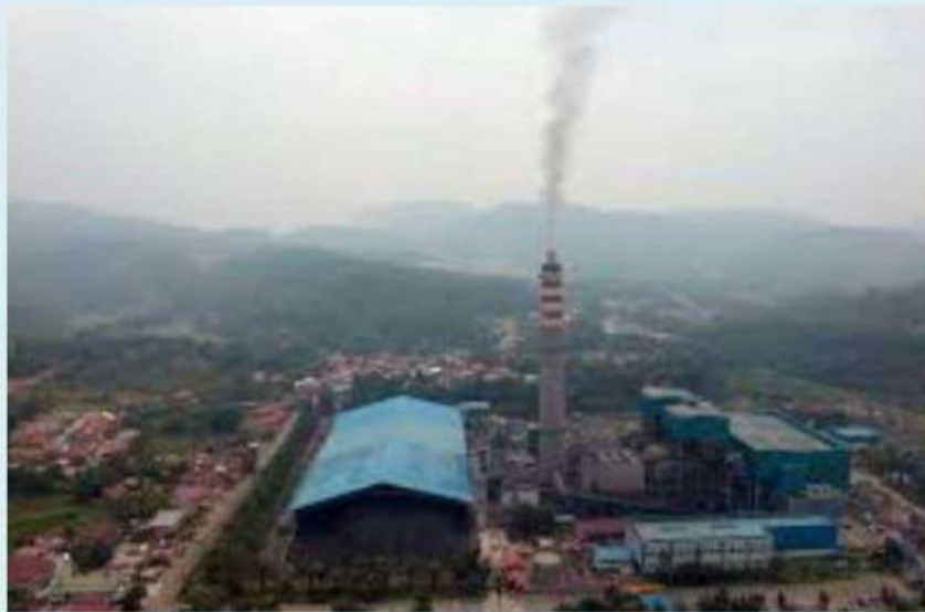
Gambar 1. Pembangkit Listrik Tenaga Uap
