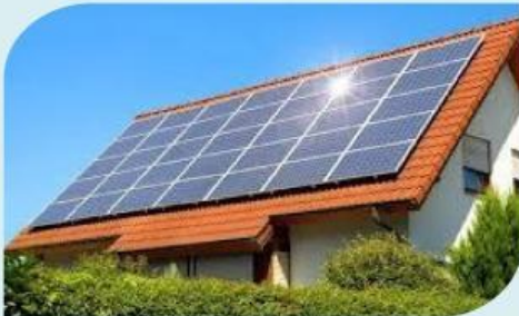
Gambar 1. Pembangkit Listrik Tenaga Surya
