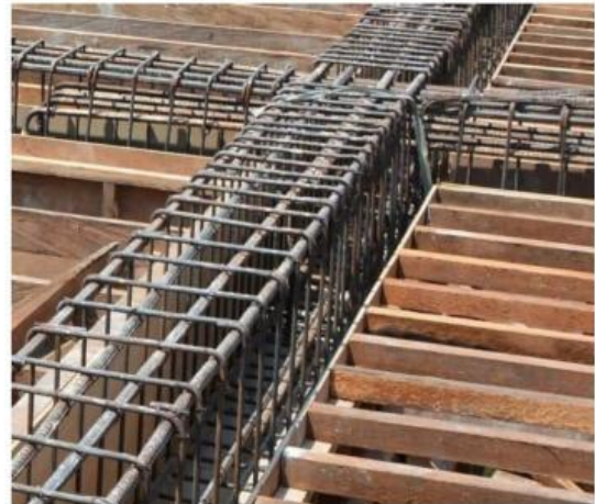
Gambar 2.1 Pengerjaan kolom beton bertulang.
