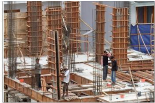
Gambar 1.1 Pengerjaan kolom beton bertulang.
