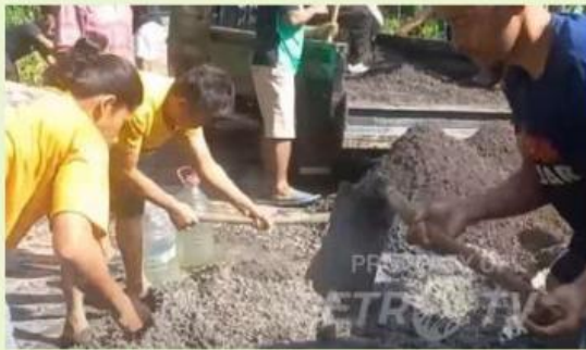
Kegiatan 1. Menutupi lubang di jalanan dengan bantuan alat sederhana
