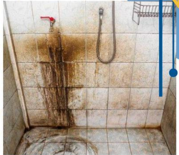
Gambar Kerak di Lantai
