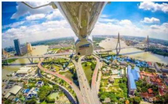
รูปถ่ายทางอากาศ
