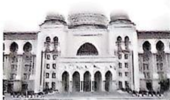
Istana Kehakiman di Putrajaya
