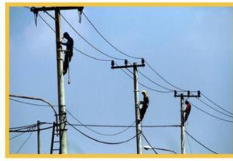
Gambar 4. Pemuaian Pada Tiang Listrik
