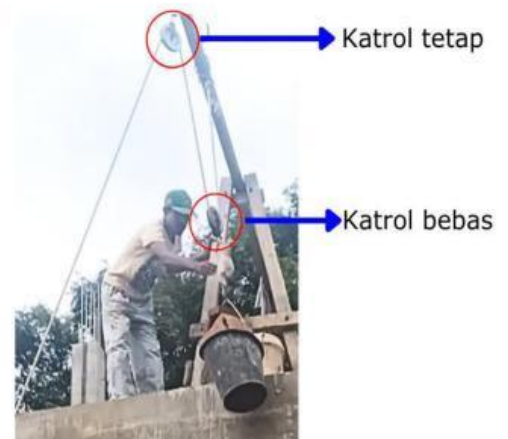
Gambar 5.10 Timba Bangunan Sumber: Youtube.com
