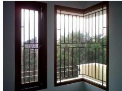
Gambar 2. Tralis Besi Jendela
