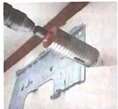
ติดตั้งแผ่นแขวนเครื่องพร้อมเจาะรูท่อออก
