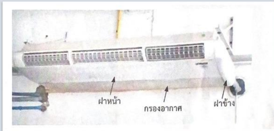
เครื่องปรับอากาศแบบแขวนเพดาน
