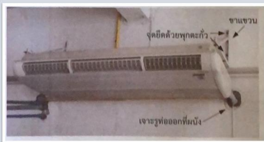
การติดตั้งชุดคอยล์เย็นแบบแขวน
