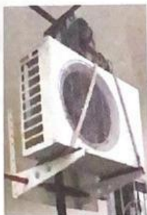
การใช้รอยกชุดคอยล์ร้อนขึ้นวาง
