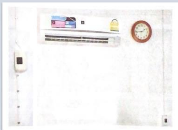
การเดินสายไฟฟ้าบนผนังคอนกรีต
