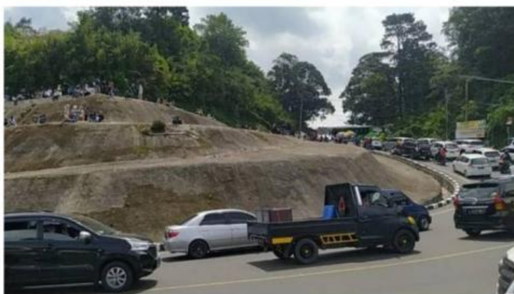
Gambar 5.1. Jalan di pegunungan Sumber : https://www.idntimes.com
