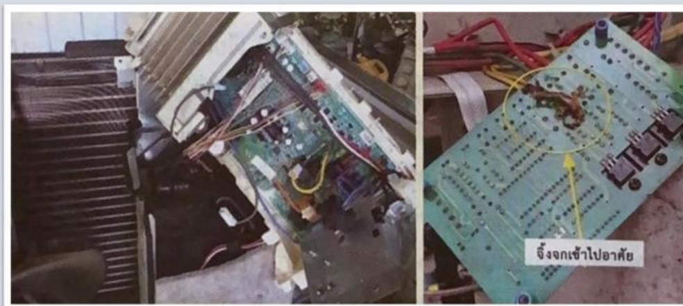
แผ่นวงจรอินเวอร์เตอร์เครื่องปรับอากาศ
