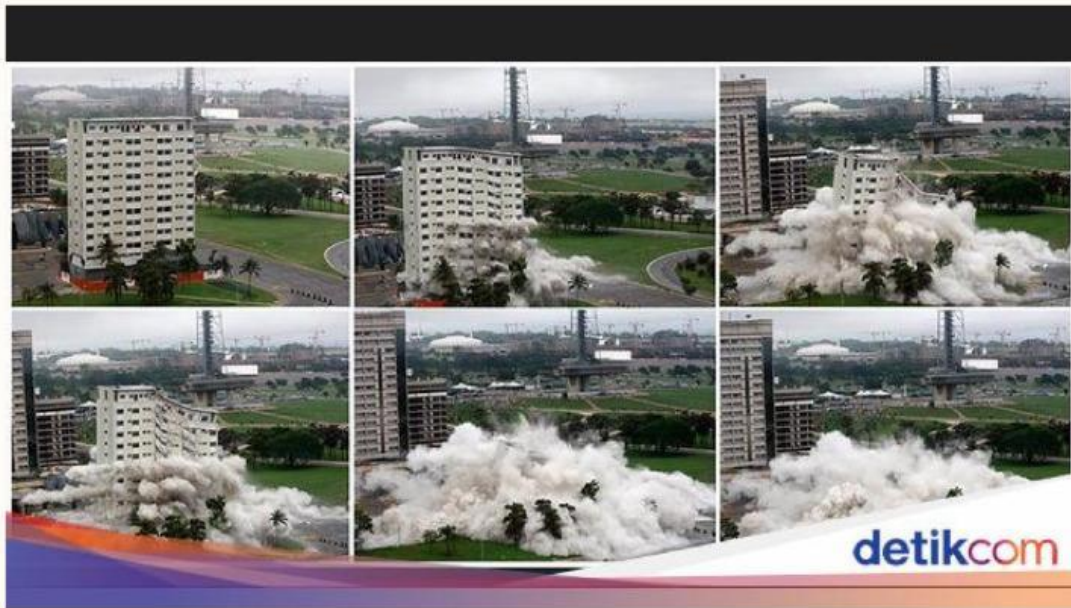
Gambar 1. Perobohan Gedung Dengan Peledakan Sumber : detiknews.com
