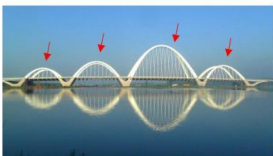
Gambar 1. Rangka atas jembatan model A berbentuk parabola dengan ukuran berbeda (source: pinterest)
