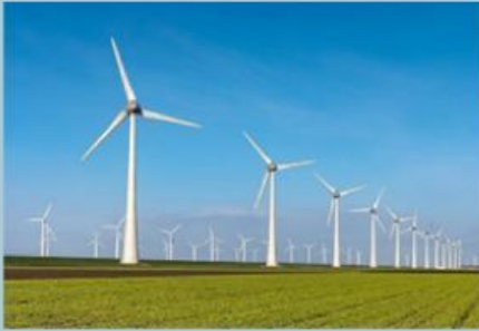
Pembangkit Listrik Tenaga Angin
