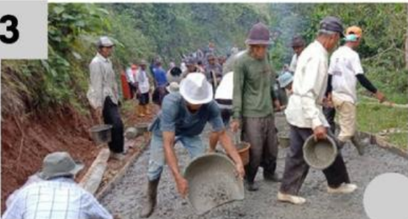
memperbaiki jalan yang rusak
